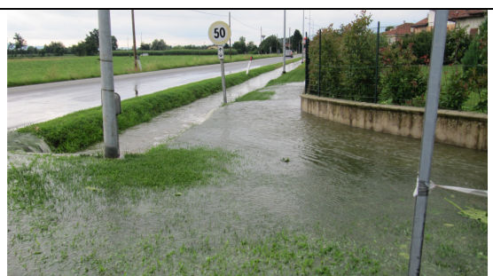
Foto n.6 – Reticolo idrografico minore in crisi, in corrispondenza dell'incrocio tra via Castegna e la SP 41 per Aglié
