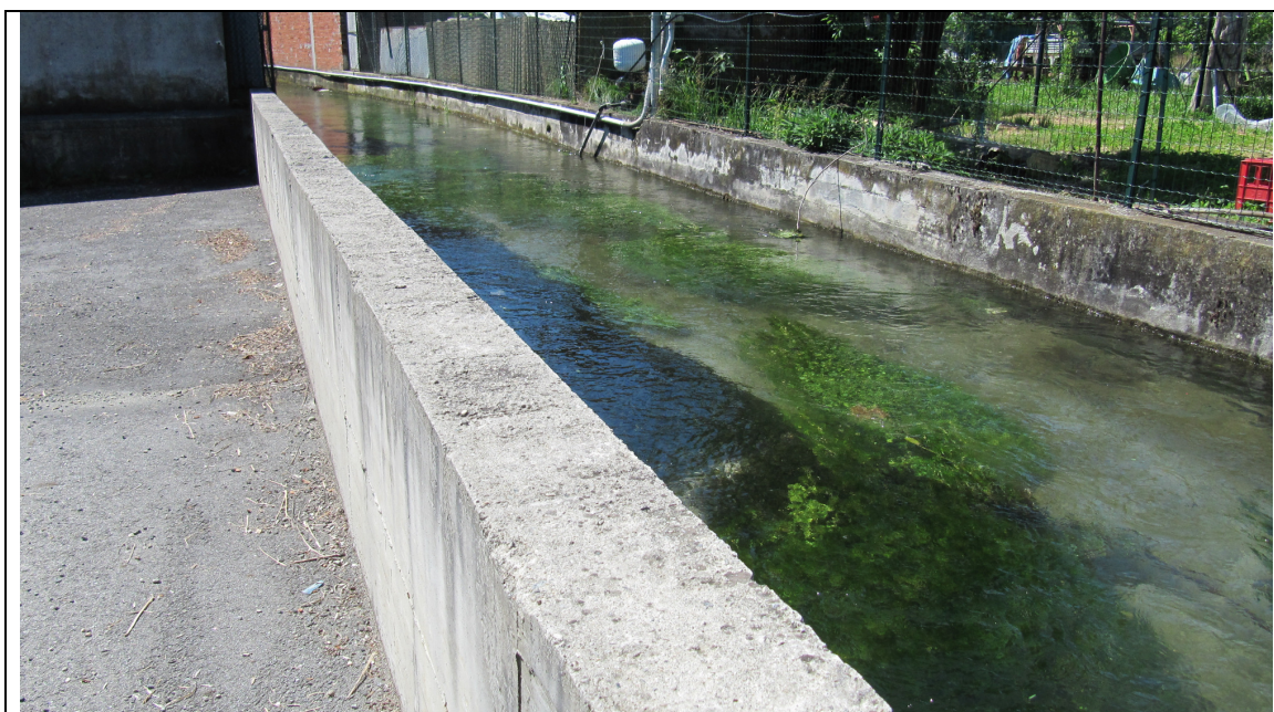
Foto n. 1 – Veduta della bealera di Ciconio all'altezza di Via Mazzini (vista da monte verso valle) . Circa 30 m oltre la curva (in alto a sinistra) , in corrispondenza con la Strada Provinciale 51 per Rivarolo , la roggia compie un salto di circa 3 metri per ritornare al di sotto del livello del piano campagna
