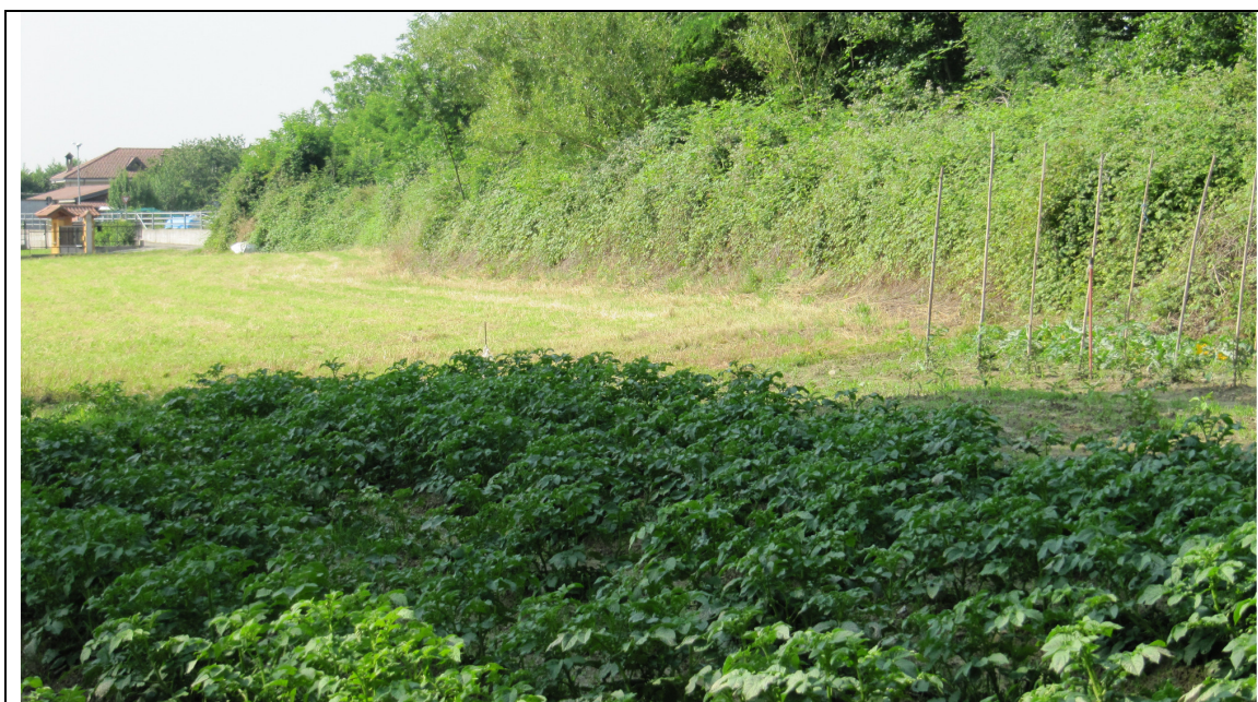
Foto n.2 - Veduta dell'argine posto in sinistra idrografica della Bealera di Ciconio . Al termine del tratto arginato (in alto a sinistra) si osserva l'opera di sistemazione evidenziata dalla foto n.1 .
